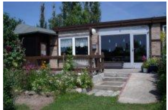
Vereinshaus mit Anbau und Terrasse
