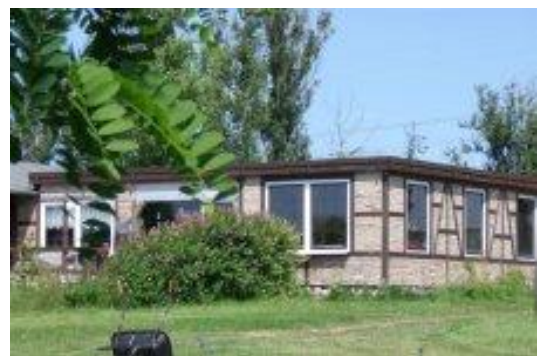
Anbau-Vereinshaus West- und Südseite
