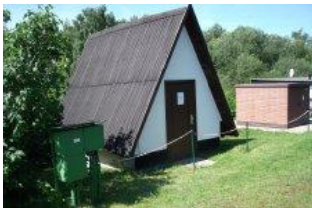
Gerätehaus (rechts daneben der neue Trafo)
