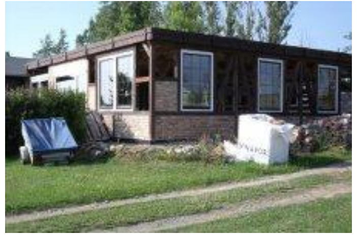
Anbau-Vereinshaus West- und Südseite 6. Juli 2012
