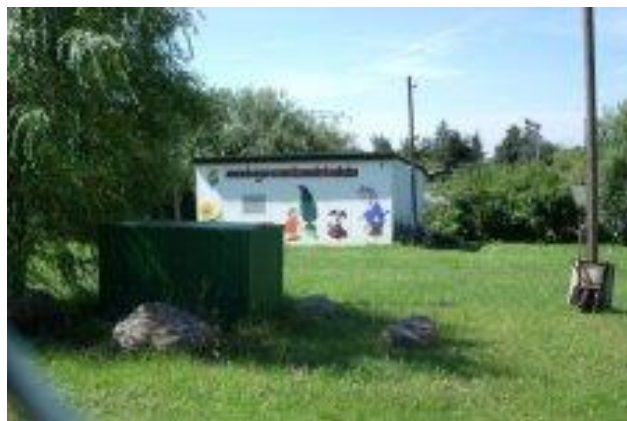
Brunnen und Pumpenhaus
