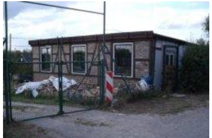
Anbau-Vereinshaus Süd- und Ostseite am 17. September 2012
