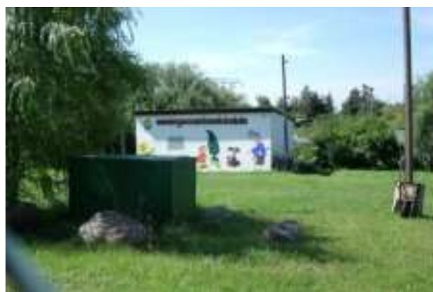
Brunnen und Pumpenhaus
