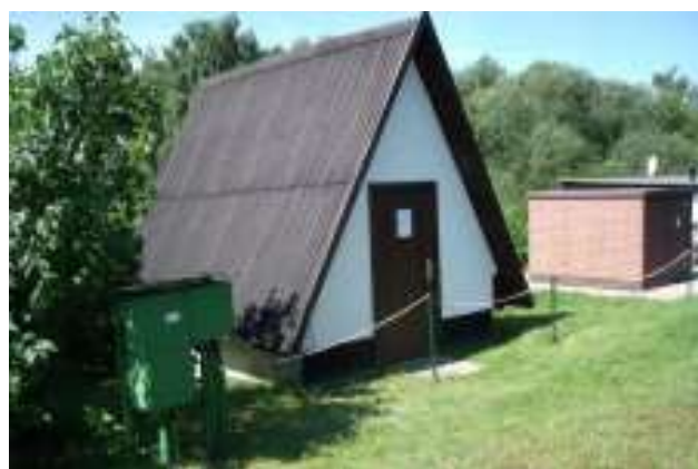
Gerätehaus (rechts daneben der neue Trafo)
