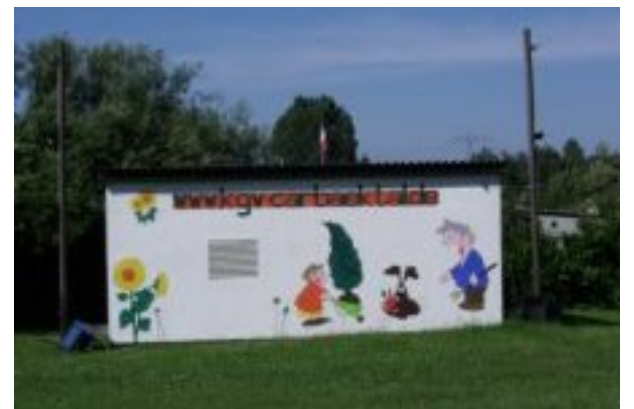
Pumpenhaus-Ostwand im Juli 2011
