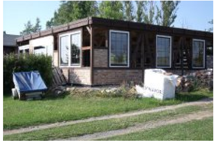
Anbau-Vereinshaus West- und Südseite 6. Juli 2012
