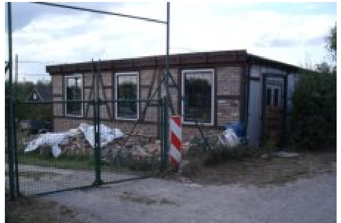
Anbau-Vereinshaus Süd- und Ostseite am 17. September 2012
