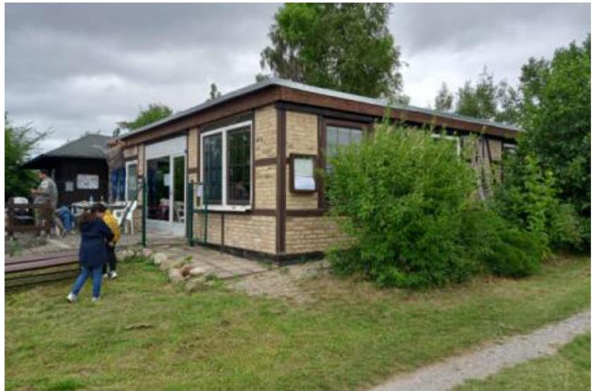
Die ursprünglich auch noch geplante Zwischendecke kann entfallen, da bereits eine deutliche Reduzierung der Geräusche von der Autobahn durch die neue Dacheindeckung erreicht wurde.
